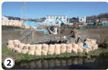
② 雨水管の付け替え工事
