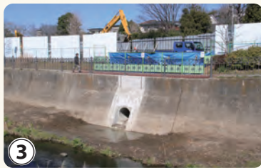
③ 雨水管の付け替え工事
