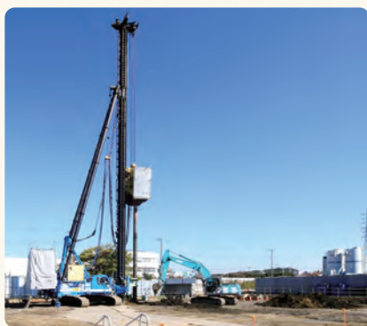
横環南栄IC・JCT改良工事 地盤改良の状況(平成26年11月10日撮影)
