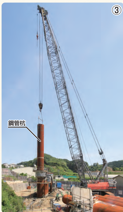
▲公田地区掘削試験工事 掘削部を工事するために、地中に鋼管杭を打設して壁をつくります
