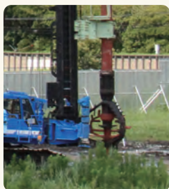
▲先端部の攪拌する翼が見えます(横環南栄IC・JCT下部(その3)工事 平成26年9月2日撮影)
