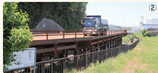
▲飯島地区整備工事 工事用道路の仮橋を河川上に整備しました
