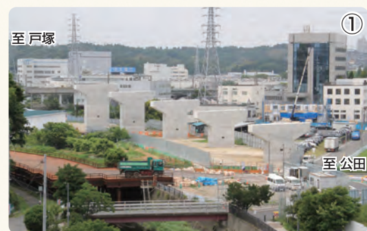
① 横浜南栄IC・JCT下部(その1)/(その2)工事(竣工済) 橋脚が完成しました
