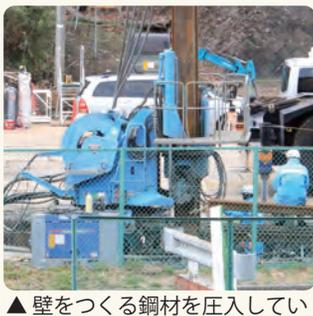
▲壁をつくる鋼材を圧入しています(平成27年3月20日撮影:地図内②の付近の作業)
