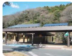
▲太陽光パネルを使って発電し、トイレのLED照明に利用。また、再生水の利用と超節水型便器の採用により、大幅な節水を実現
