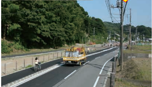
▲歩道整備や車道の拡幅で、より安全に
