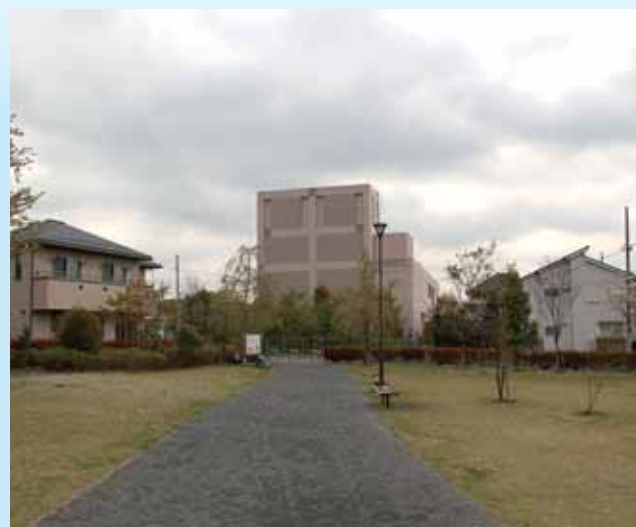
圏央道青梅換気所(写真中央部)住宅地の景観との調和に配慮▶
