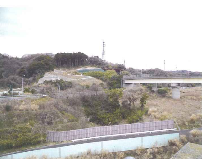
▲釜利谷JCTの工事状況
