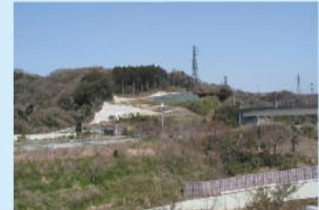
▲ 釜利谷ジャンクションの工事状況
