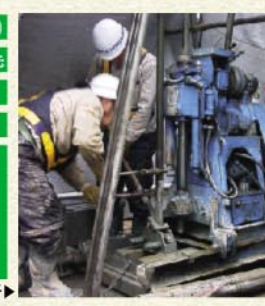
ボーリング調査の様子
