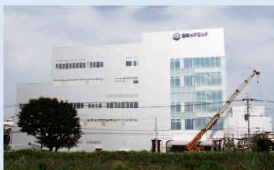
▲着々と建設が進む新海老名工場。平成26年3月末の完成・稼働を目指す。
