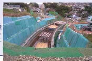
県道浦賀港線 桜ヶ丘付近馬堀IC(仮称)ランプのボックスンネルを造っています。この上に土を埋め戻して本線を通します
