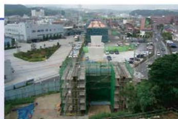
県道浦賀港線 桜ヶ丘付近馬堀IC(仮称)ランプのボックスンネルを造っています。この上に土を埋め戻して本線を通します
