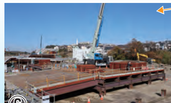
⑥ 掘削するための栈橋を設置しています
