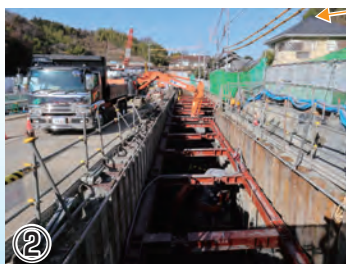
② 埋設物である水路の付け替えのために掘削を行っています
