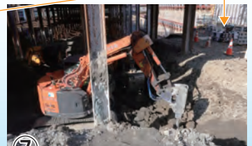
⑦ 栈橋の下を掘削しています
