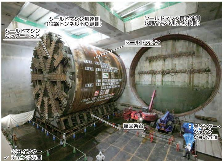
回転立坑内シールドマシンの到達状況(シールドマシンを押し出し回転架台に載せた状況)
