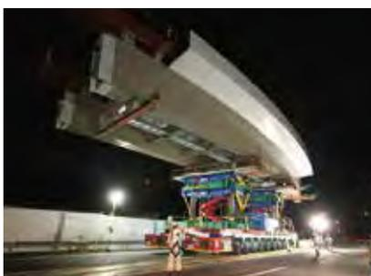
▲ 橋梁を載せて高速道路上を移動する多軸台車
