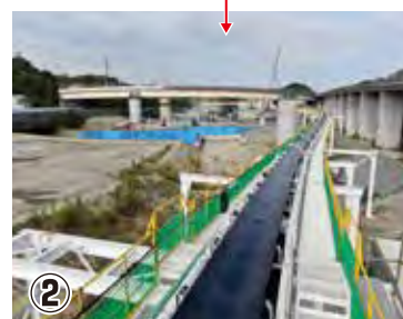
▲土砂搬送用ベルトコンベアの設置状況(釜利谷ジャンクション内)
