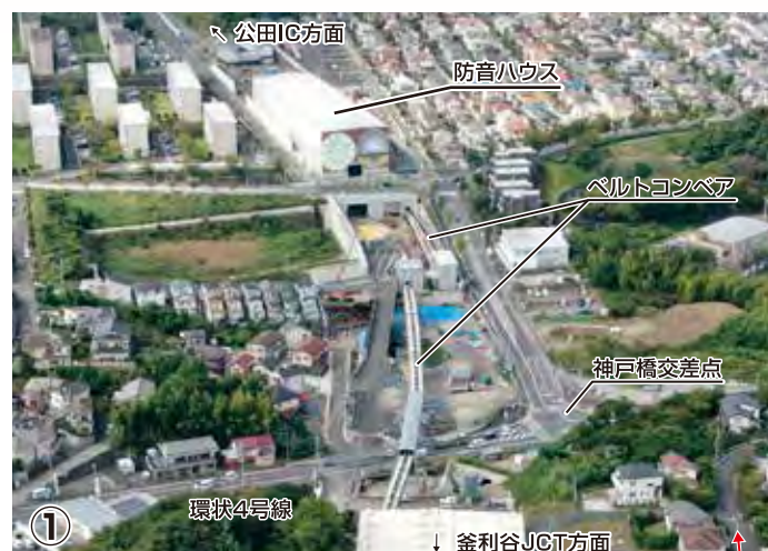
▲発進到達立坑の防音ハウスと土砂搬送用ベルトコンベアの設置状況(上郷町付近)
