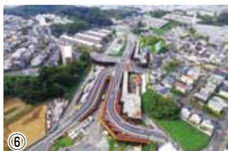
⑥ 公田地区掘削試験工事 迂回道路(仮橋道)へ交通を切り替え、その下の部分の掘削などを行っています
