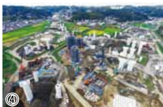
④ 横環南栄IC・JCT下部工事他 インター・ジャンクション内の橋梁の橋脚などの施工を行っています
