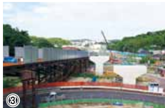
③ 横浜湘南道路小雀高架橋下部工事他 橋梁の橋脚などの施工を行っています
