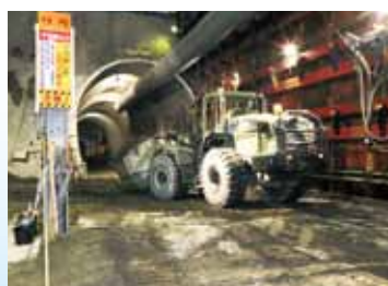
▲パイロットトンネル入口付近。奥で掘削した土をホイールローダーでかき出しています
