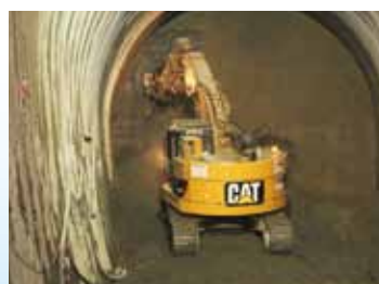
▲ツインヘッダー(油圧切削機)による掘削。ヘッド部分を回転させて土を削ります
