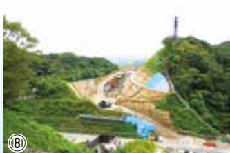
⑧ 釜利谷ジャンクション工事 ジャンクション内新設ランプ部分の切土工事を行っています
