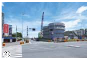
① 横浜湘南道路藤沢立坑工事 トンネルを掘るシールドマシンを折り返すための立坑を施工しています
