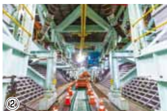
② 横浜湘南道路トンネル工事 シールドマシンによる掘削の準備を行っています
