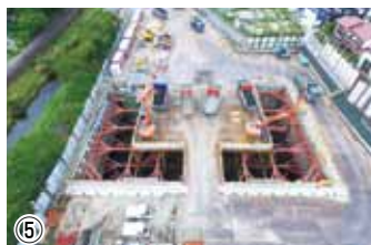
⑤ 公田笠間トンネル工事 発達到達立坑の掘削を行っています
