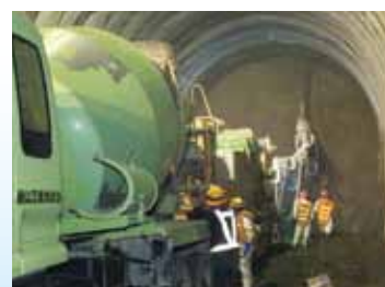
▲掘削面が崩れないようにコンクリートを吹付けます
