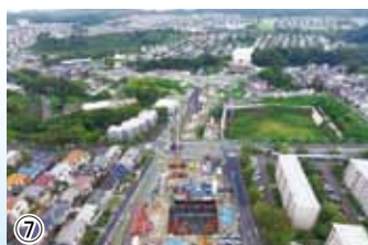
⑦ 桂台トンネル工事 発達到達立坑の構築などを行っています
