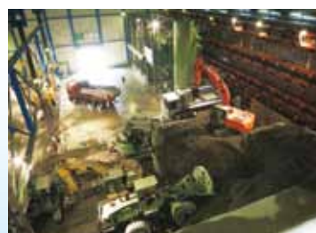
▲防音ハウス内部のようす。掘削した土を仮置きする場所やトンネル内に吹付けるコンクリートのプラントなどがあります
