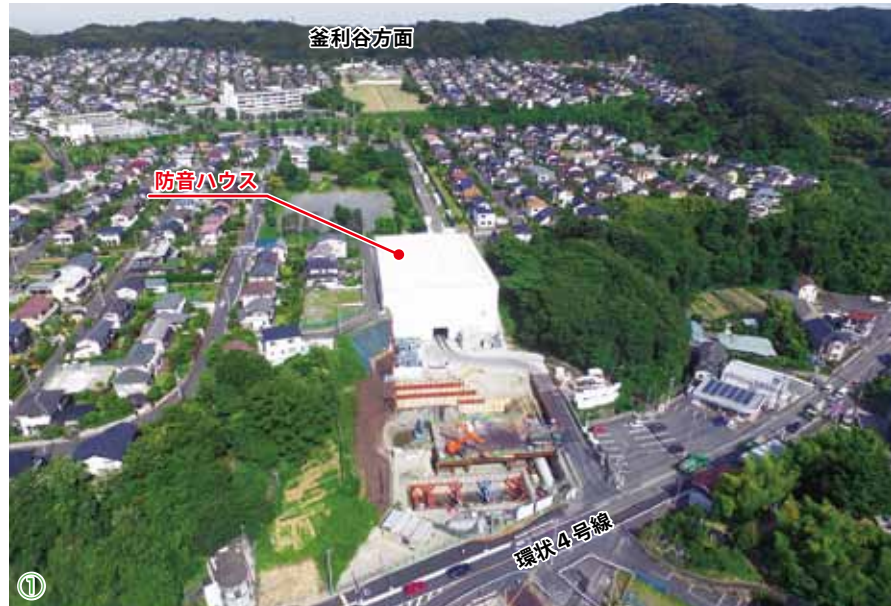
▲環状4号線側作業ヤードの防音ハウス。 幅約35m、奥行き約50m、高さ手前側約18m、奥側約6m
