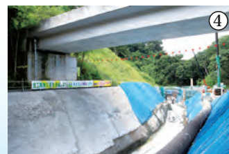
釜利谷地区整備工事 釜利谷ジャンクション内の工事用進入路 設置のため遊歩道の整備を行っています ※写真は2015年5月～8月に撮影
