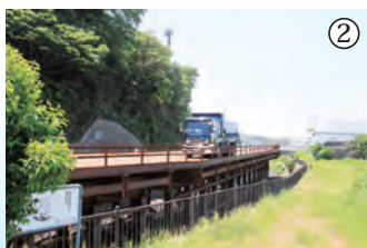
飯島地区整備工事 工事用道路の仮橋を河川上に整備しました
