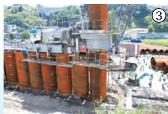
公田地区掘割試験工事 掘割部の工事をするために、地中に鋼管の杭を打ち込んで壁をつくっています
