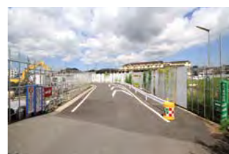
飯島地区整備工事 工事のために元の道を迂回させ、通行できるようにしています。
