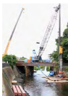
飯島地区整備工事 工事用道路の仮橋を河川上に整備しています。
