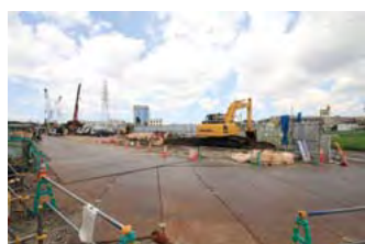
横環南栄IC・JCT下部(その1)工事 橋脚の基礎の部分の工事をしています。
