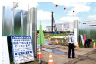
横環南栄IC・JCT下部(その3)工事 橋脚の基礎の部分の工事をしています。
