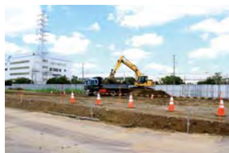
横環南栄IC・JCT改良工事 土にセメントを混合させて地盤を強くする工事をしています。
