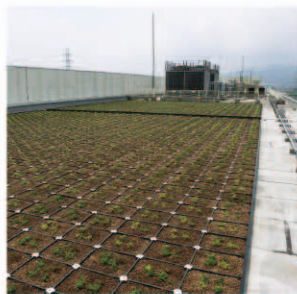
▲メンテナンスのいらないセダム植物などを植栽し、建物内温度の上昇を抑制。地球環境に貢献しています。
