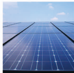
▲屋上に設置された太陽光発電システム。昨年度は全社で約430世帯分の年間使用量に相当する年間約145万kWhを発電。約625万トンのCO 2 を削減しました。
