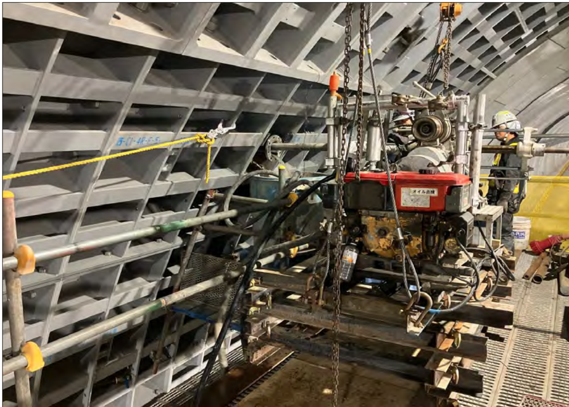
水平ボーリング施工状況
