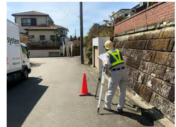
地表面変位計測状況
