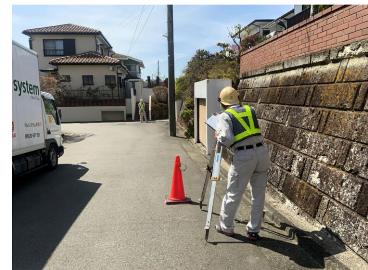
地表面変位計測状況
