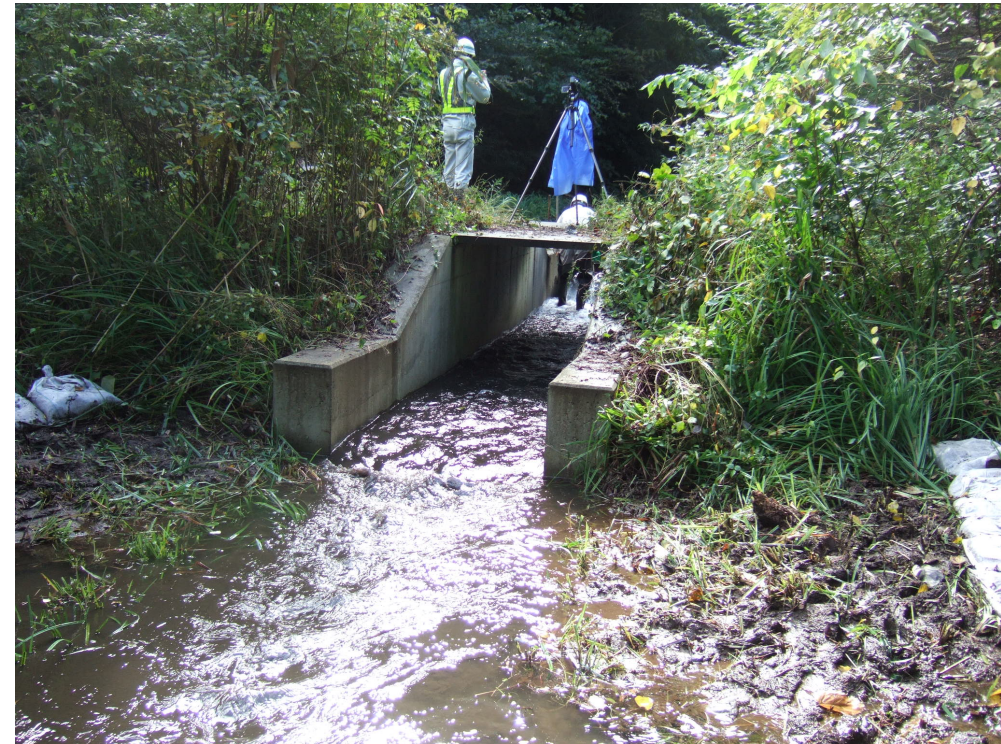
フラッシュ実施状況（下流堰板を開放した直後）
