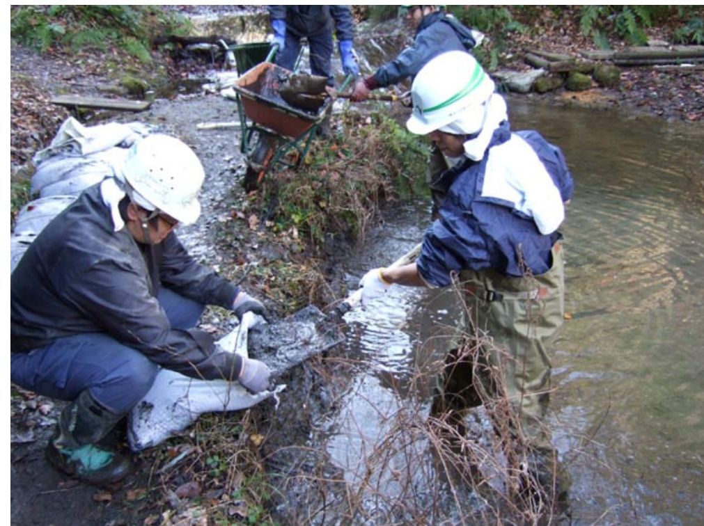
人力による土砂掘り取り作業状況（平成22年1月）
