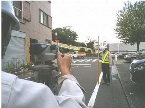
地表面沈下測定
