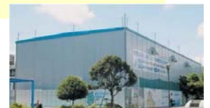
防音ハウス外観(事例)
