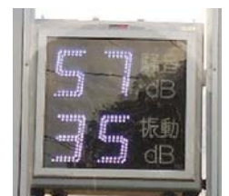
測定値表示例 (飯島地区河川 閉塞工事)
