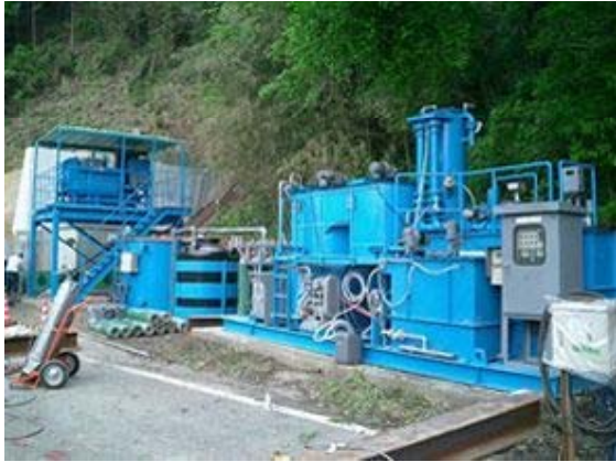
濁水処理装置
