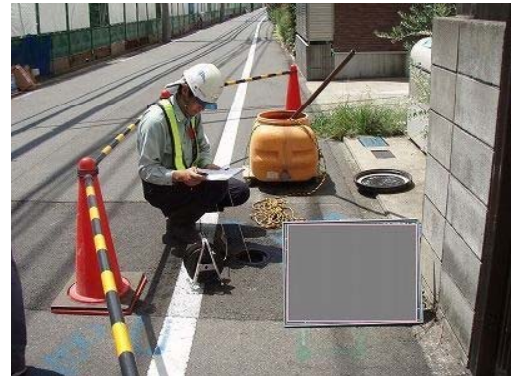
地下水位観測
