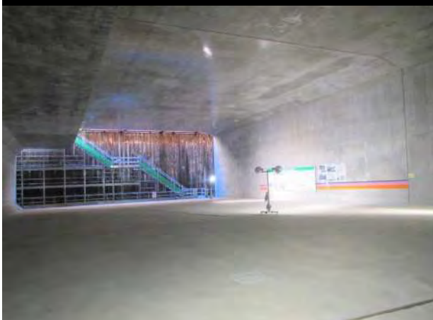
I 函渠工区 施工状況
