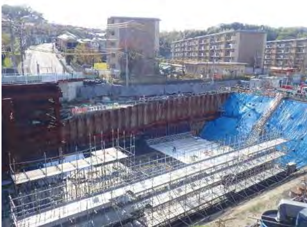
III ランプ工区 (Dランプ) 施工状況
