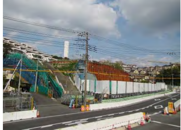
IV グリーンテラス本郷台 施工状況
