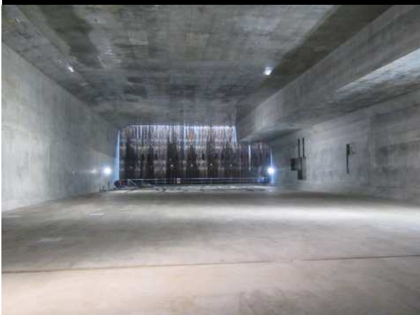
I 函渠工区 施工状況
