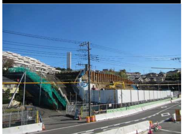
IV グリーンテラス本郷台 施工状況
