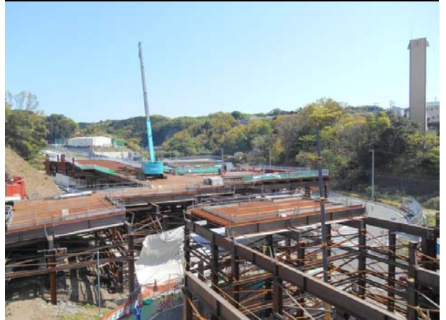
④ランプエ区 Aランプ 迂回道路（仮橋道路）施工状況
