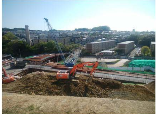
②ランプエ区 Aランプ 斜面切土施工状況
