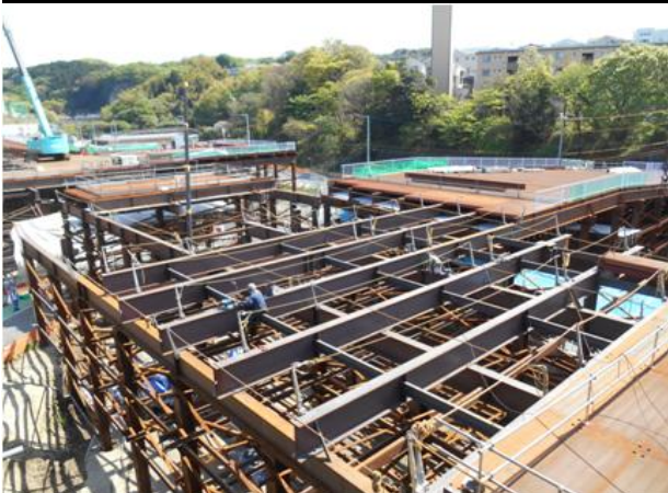
③ランプエ区 Aランプ 迂回道路（仮橋道路）施工状況
