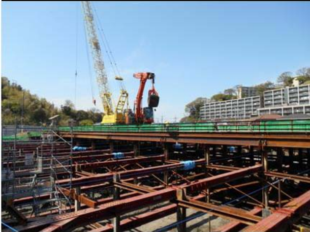
①函渠工区 掘削状況
