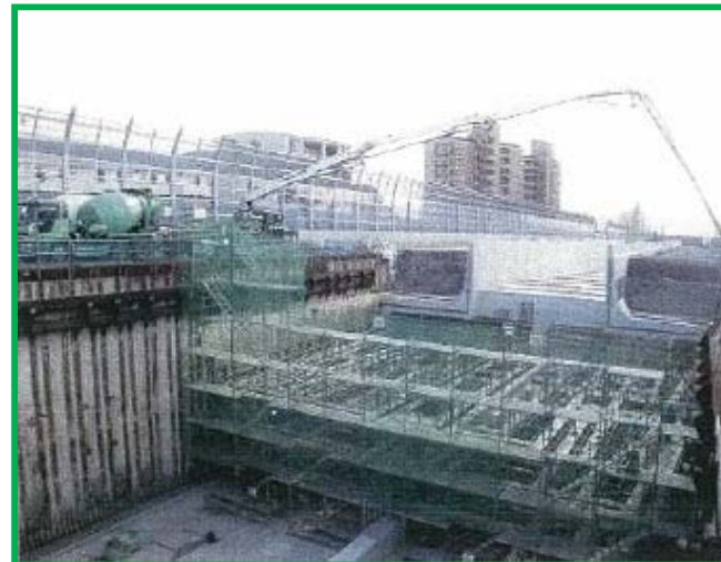
⑤コンクリート打設
