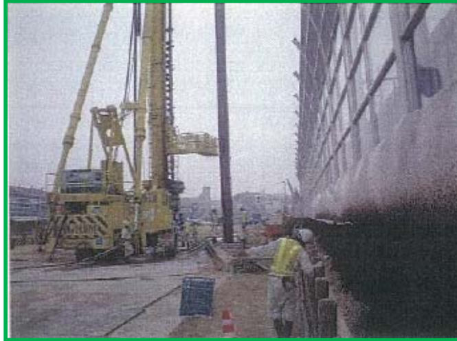
②山留工(芯材立て込み)
