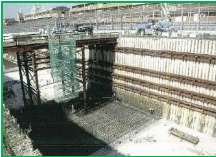
④鉄筋組立
