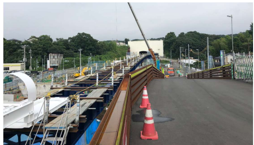
ベルトコンベア設置状況
