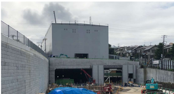
防音ハウス設置状況
