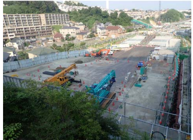
施工現場写真
