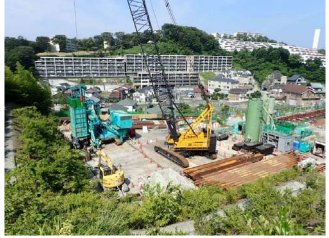
施工現場写真
