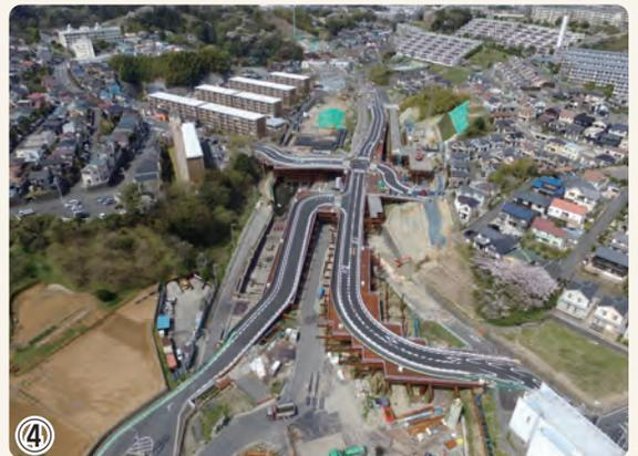
▲公田地区掘削試験工事 迂回道路(仮橋道)へ交通を切り替え、その下の部分の掘削を行っています
