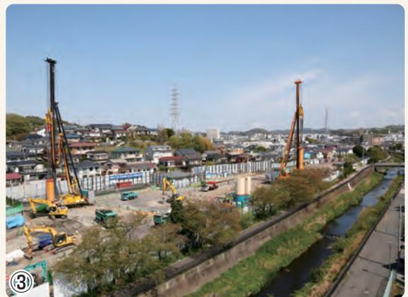
▲公田笠間トンネル工事 シールドマシンを発進及び到達させる立坑を掘る準備をしています
