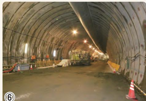
▲釜利谷ジャンクションCランプトンネル工事 釜利谷ジャンクション側からトンネルを掘っています
