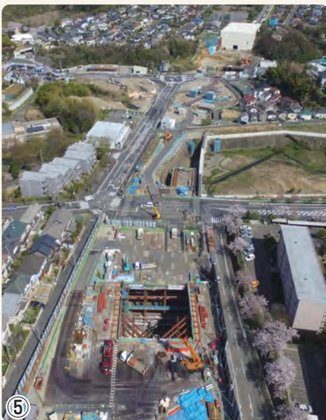
▲桂台トンネル工事 シールドマシンを発進及び到達させる立坑の躯体の構築を行っています
