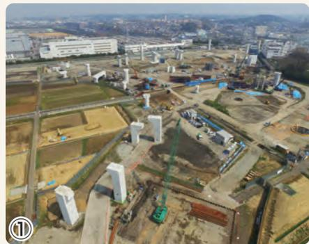
▲横環南栄IC・JCT下部工事(写真①~②) インター・ジャンクション内の橋梁の橋脚の施工を行っています
