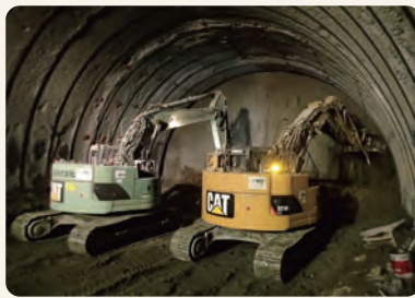
▲NATM工法による掘削状況
