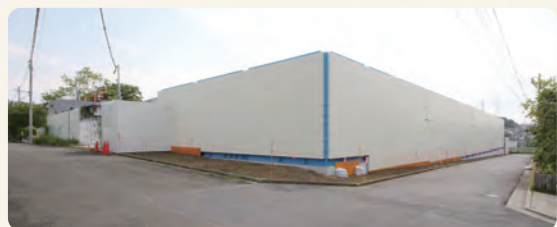
▲トンネル作業ヤード外側の防音パネル
