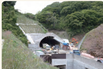
▲釜利谷ジャンクション側トンネル坑口
