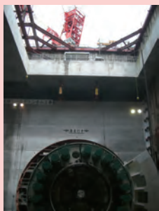
発進立坑(参考写真)
