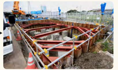
横環南栄IC・JCT下部(その1)工事 掘削後、杭の頭部が露出している状況 (平成26年10月8日撮影)
