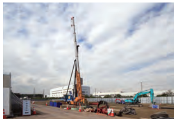
横環南栄IC・JCT改良工事 土にセメントを混合させて地盤を強くする工事を進めています
