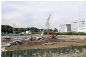
横環南栄IC・JCT下部(その3)工事 橋脚の基礎の部分の工事を進めています
