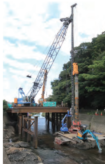
飯島地区整備工事 工事用道路の仮橋を河川上に整備しています
