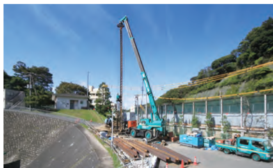
釜利谷地区整備工事 日野すい道の補強工事(写真)、及び釜利谷ジャンクション内の歩道や工事用進入路の整備を行っています ※写真は2014年10月に撮影
