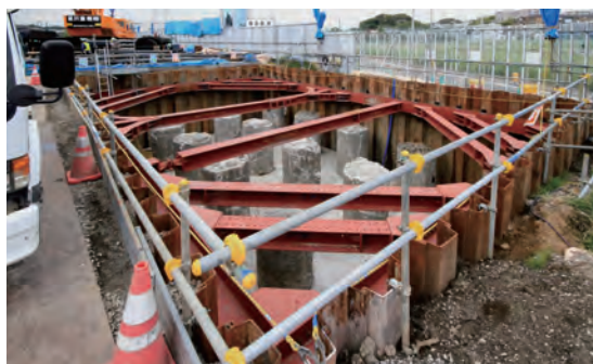
横環南栄IC・JCT下部(その1)工事 橋脚の基礎の部分の工事を進めています
