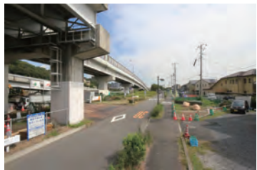
横浜湘南道路オンランプ橋下部他工事 新湘南バイパスにつながるオンランプ橋の工事を進めています
