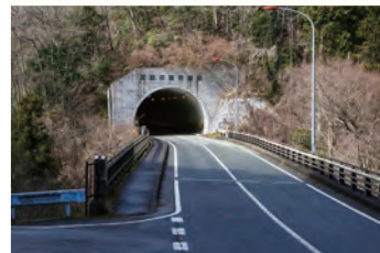
地蔵堂トンネル (ナビスポットE)
