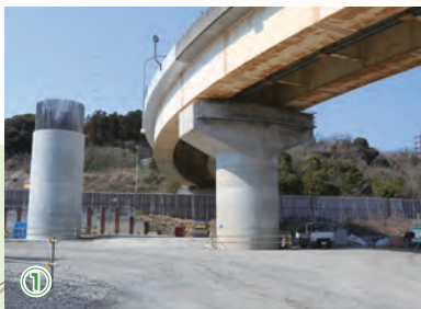
① ランプ部橋梁の橋脚の施工
